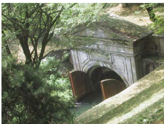
伊藤博文の石額のある第1トンネル東口洞門
